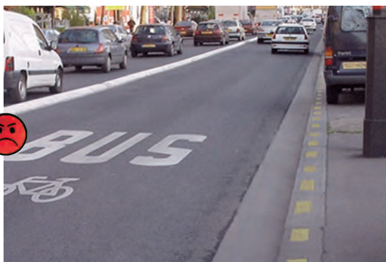
Exemple de bourrelet difficilement perceptible en raison du marquage continu.
