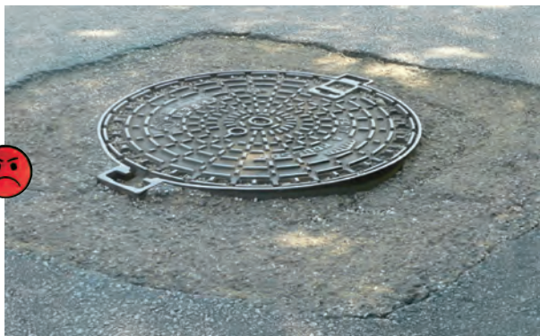
Exemple de plaque dont le scellement est en cours de détérioration.
