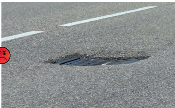
Exemple de bouche d'égout située au milieu de la chaussée et n'étant pas à niveau de celle-ci.
