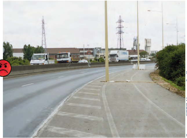
Candélabre non isolé en courbe, sur une section à deux voies.
