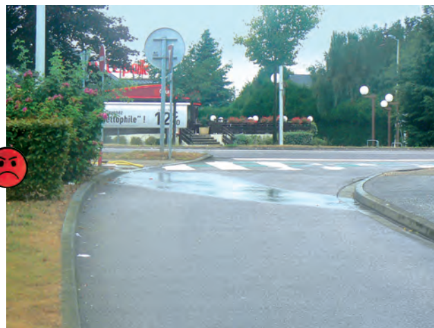
Arrosage avec écoulement d'eau sur la chaussée à l'abord d'un STOP en courbe. Contrairement à une chaussée mouillée par la pluie, l'usager n'aura pas forcément anticipé une glissance ponctuelle du sol.
