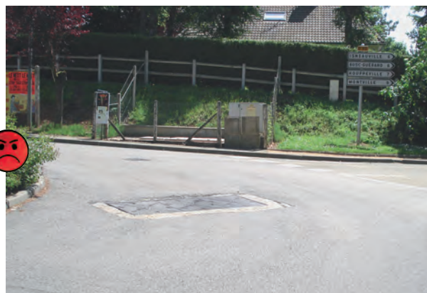
La trajectoire d'un 2RM effectuant un tourne-à-gauche passe sur la plaque non revêtue située sur l'anneau d'un giratoire.
