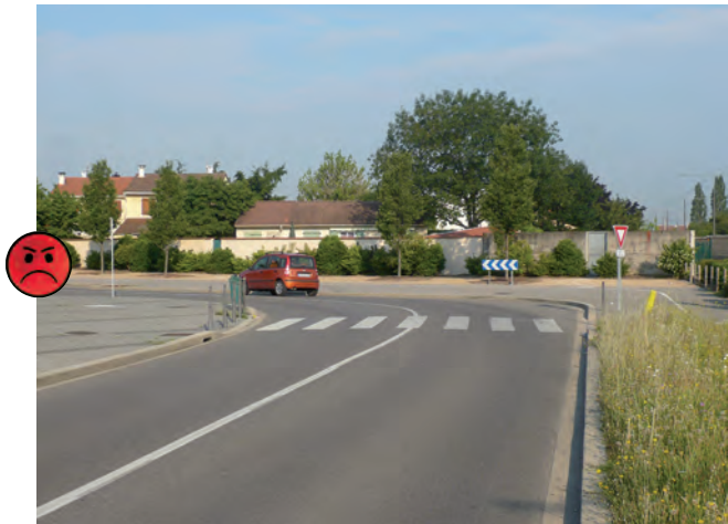
Passage piéton en virage pouvant déstabiliser un 2RM.
