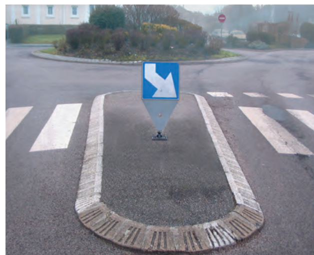
Système de signalisation J5 autorelevable sur îlot séparateur de giratoire en France.
