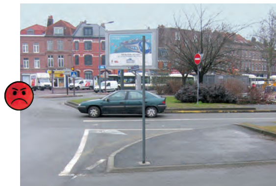
Obstacle inutile : support de panneau de signalisation non utilisé en sortie de giratoire sur trajectoire possible d'un 2RM en cas de perte de contrôle.
