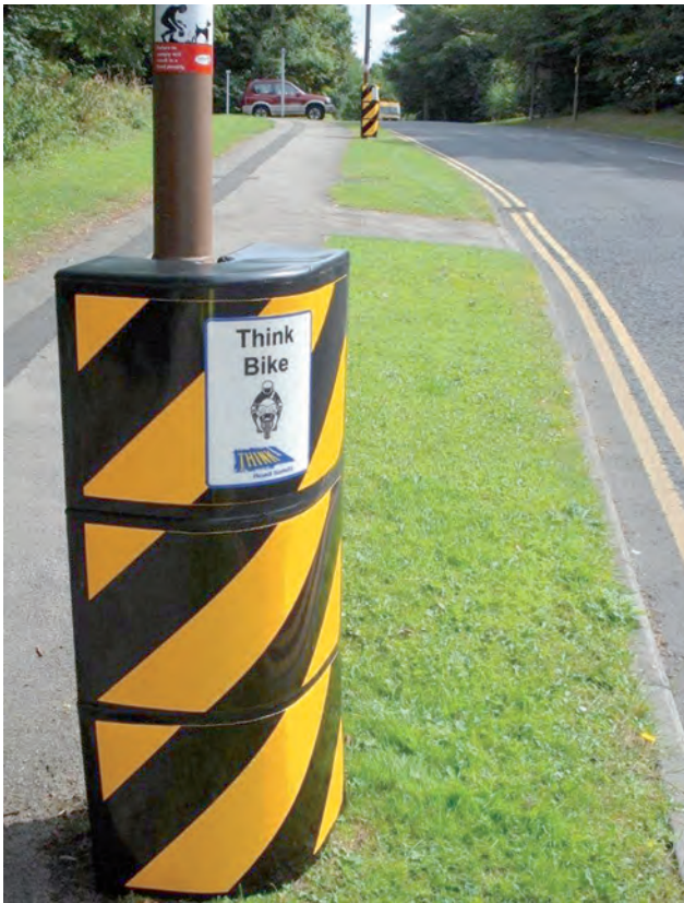
Illustration d'un support de signalisation équipé d'une coque atténuant le choc.
