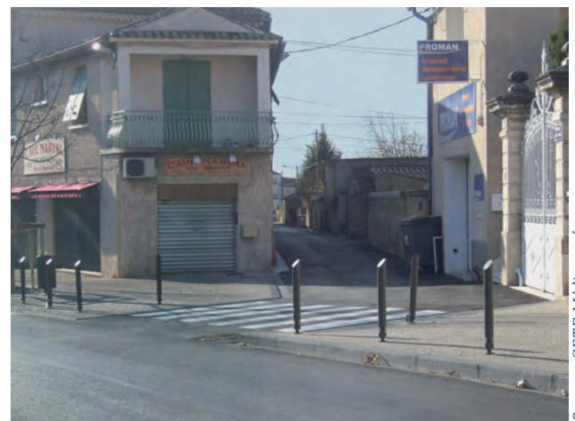
L'extrémité biseauté des potelets utilisés ici peut présenter un danger pour les usagers deux-roues motorisés.
