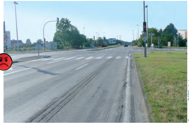
Exemple de rabotage permanent de la chaussée utilisé pour compenser l'orniérage de la chaussée. Ce rabotage est dangereux pour un usager 2RM, car il se situe en zone de freinage.
